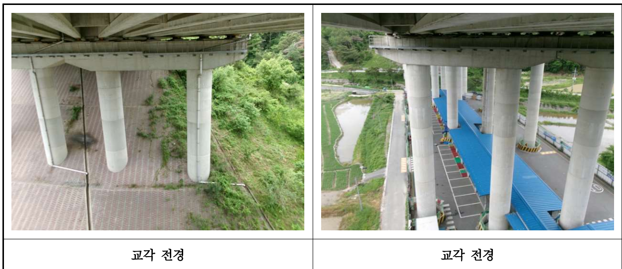
【사진 29.3.10】 교각 전경
