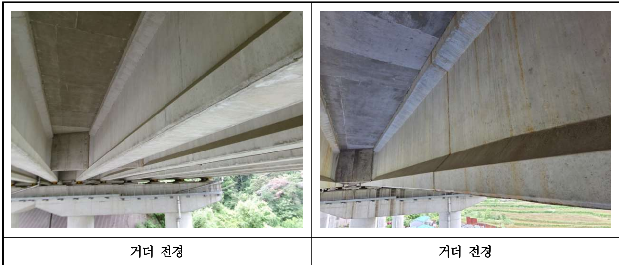
【사진 29.3.4】 거더 전경
