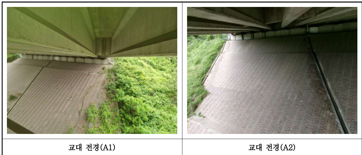
【사진 29.3.8】 교대 전경
