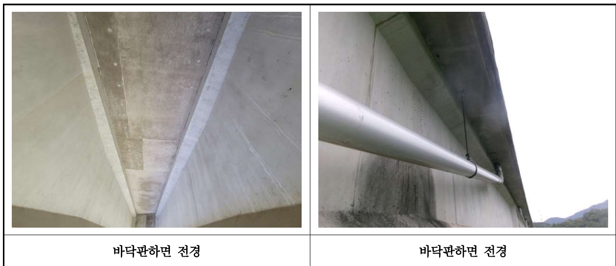
【사진 29.3.2】 바닥판하면 전경
