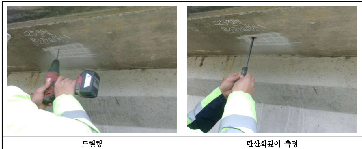
【사진 29.4.3】 탄산화 깊이 측정 현장사진
