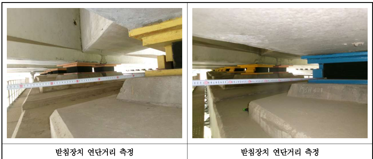
【사진 29.3.15】 교량받침장치 연단거리측정
